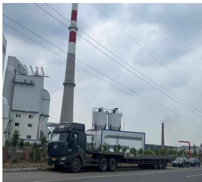
西侧，哈电集团生物质发电德惠有限公司
